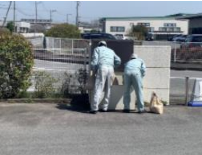
④ 土嚢を準備
