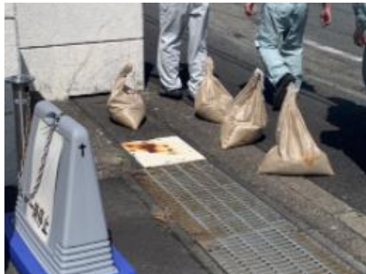
⑤ 土嚢投入前
