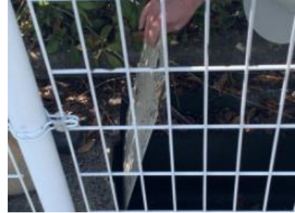
③ 流出防止板を挿入する
