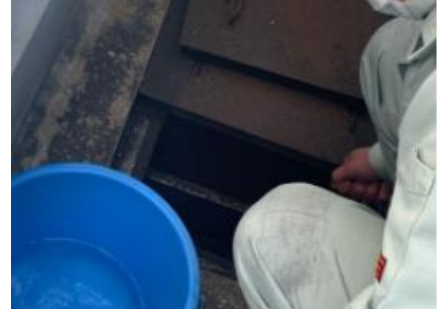
⑥ 油升内の廃油汲み取り
