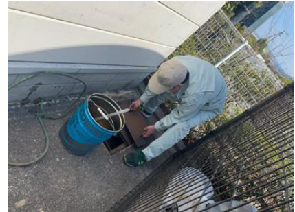
⑥ 油升内の廃油汲み取り
