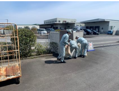
④ 土嚢を準備
