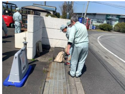
⑤ 土嚢を投入
