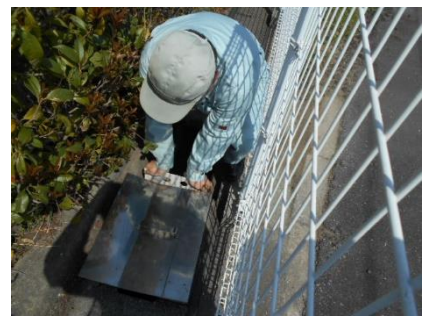
③ 流出防止板を挿入する
