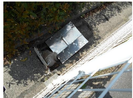
③流出防止板を挿入する
