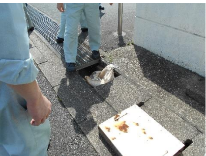
④土嚢を投入
